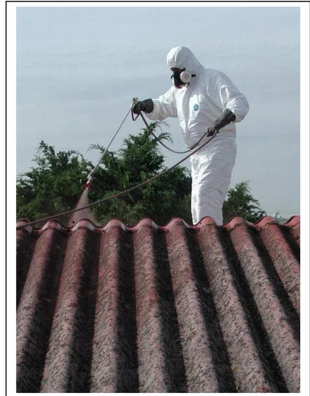
3- Rimuovere i ganci o le viti di fissaggio delle lastre avendo cura di non danneggiare le lastre utilizzando solamente utensili manuali.
